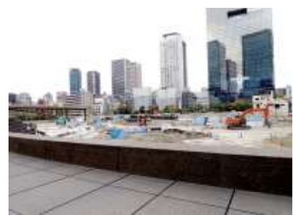
うめきたの森は工事中 241124 撮影 柗元慶子
