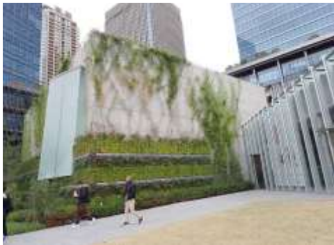
ノースヒルにある建物の壁面緑化 ネットを張り、上下から絡みつかせている 241124 撮影 柘元慶子
