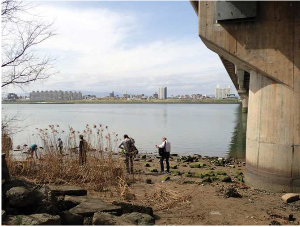
十三バイパス国道 176 号橋脚横から水面に近づく 180318 撮影 榎元慶子
