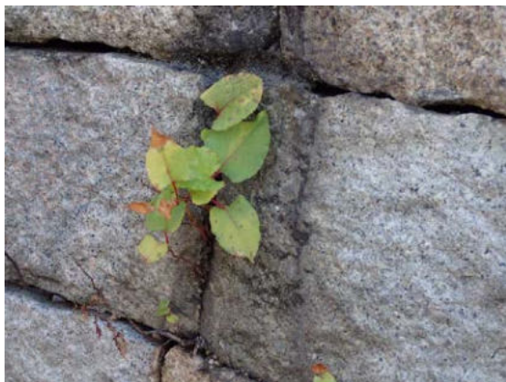
石垣の隙間からイタドリ:清水坂 170219 撮影 榎元慶子
