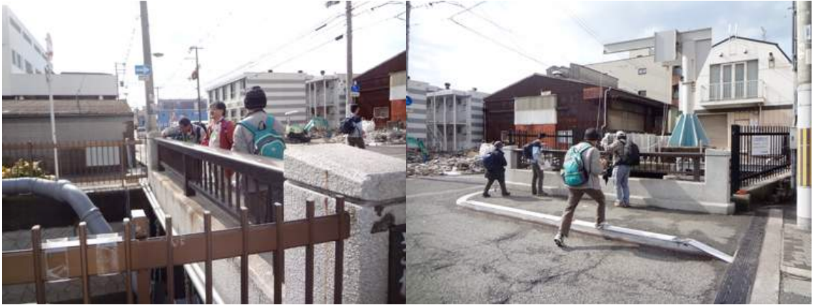
記念橋の東(左写真)と西(右写真):加美巽川は護岸工事中で、水位の調整のために、サイホンで西側の水門に流していました。160214 撮影 北川ちえこ
