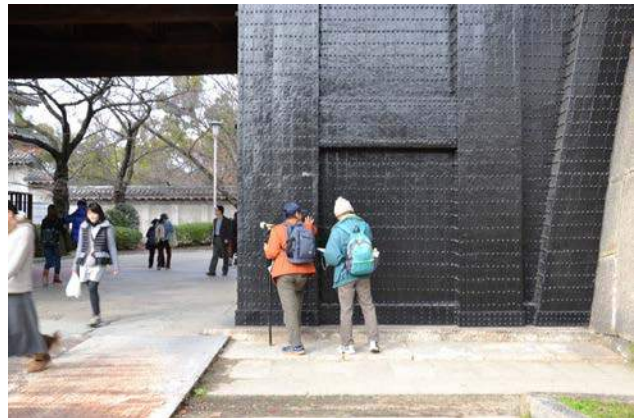
多聞櫓黒塗り鉄扉の表面温度を測定中 日なたと日かげで大きく違った。 151213 撮影 柘元慶子
